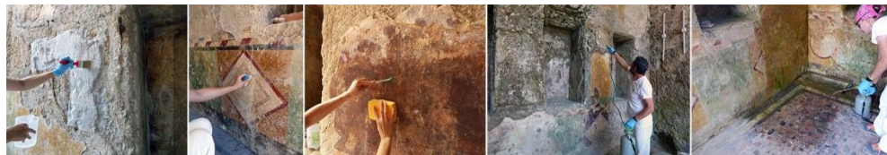
Figura 7 – Interventi di restauro – Società Lithos Restauri Srl, Venezia. Posizionamento garze, pulitura con Wishub, rimozione sali, stesura biocida.
