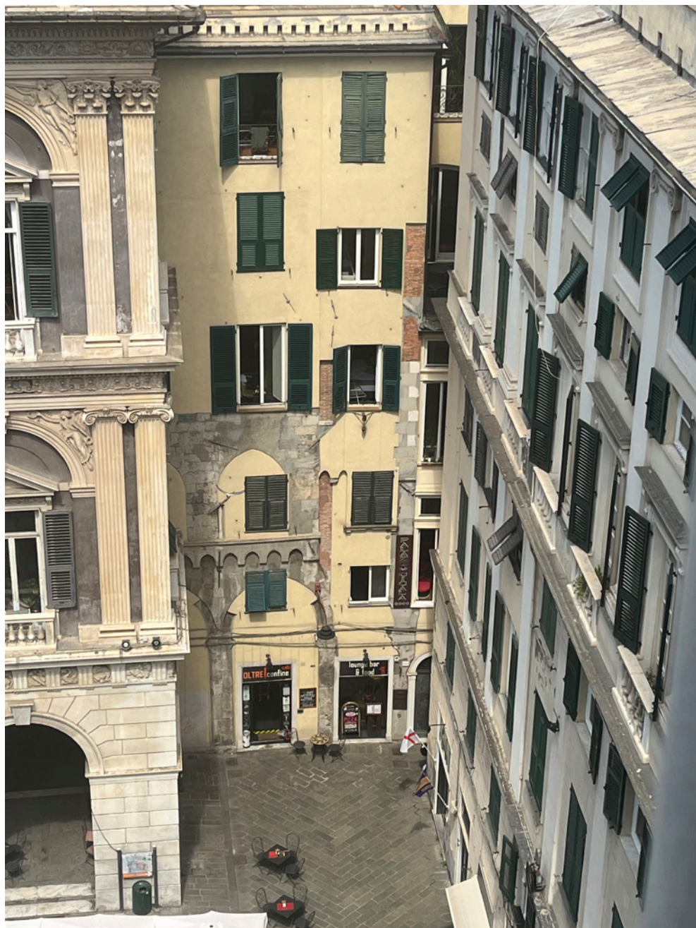
Figura 11. Piazza San Lorenzo, imbocco del vico attualmente denominato Invrea con edifici, riconoscibili come proprietà de Nigro dal tardo secolo XIII, recanti i dettagli architettonici basomedievali (Fotografia di D. Bezzina).
