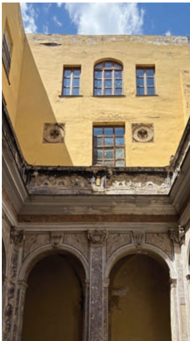
31. Complesso di s. Maria di Donnaregina. I resti del semiarco a sesto ribassato del portichetto tardo quattrocentesco che si estendeva secondo Chierici lungo il lato sud-ovest dell'atrio della chiesa; lato verso le arcate trecentesche (vedi lettera B, fig. 24, fig. 7 del testo di Chierici)
