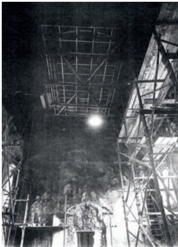
21. Vista dell'abside e del muro del coro della chiesa seicentesca prima dell'intervento di spostamento del muro (FDRMNC)
