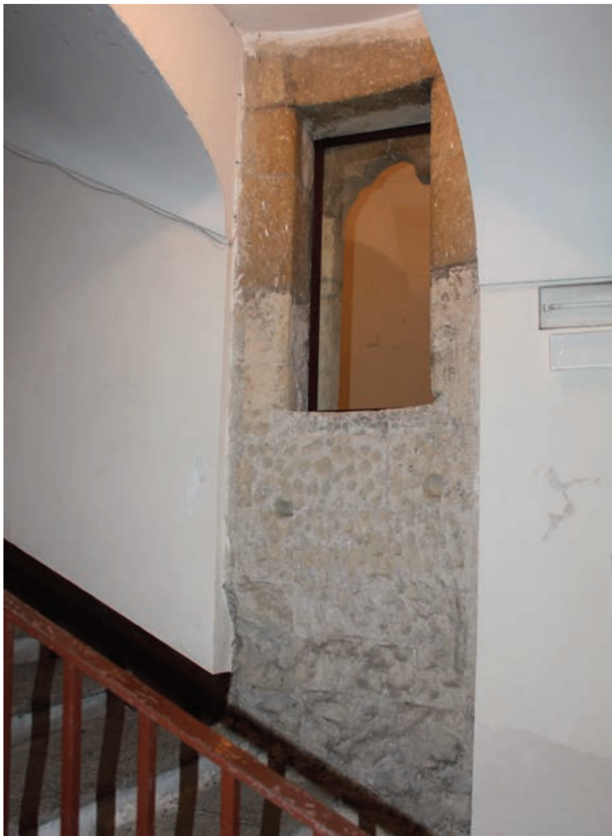
28. Complesso di s. Maria di Donnaregina. Gli avanzi della scala a chiocciola (E) visti dall'attuale scala di accesso al primo del coro. Vedi fig. 23
