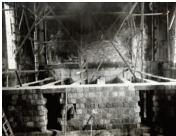
28. I muri realizzati per lo spostamento della parete di fondo del coro seicentesco (FDRMNC)
