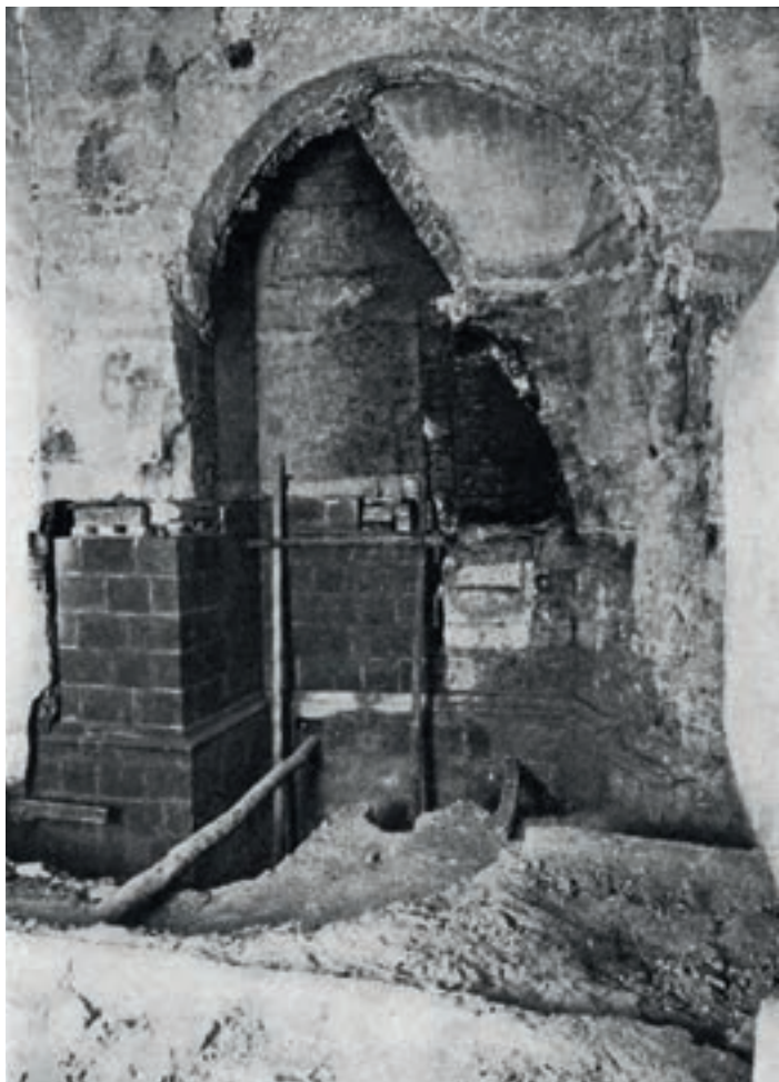
15 I lavori di ripristino dell'abside (AF SABAPNa)
