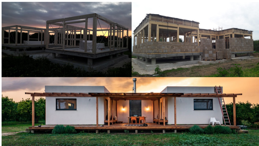
Esempio costruzione casa singola, struttura in legno.
