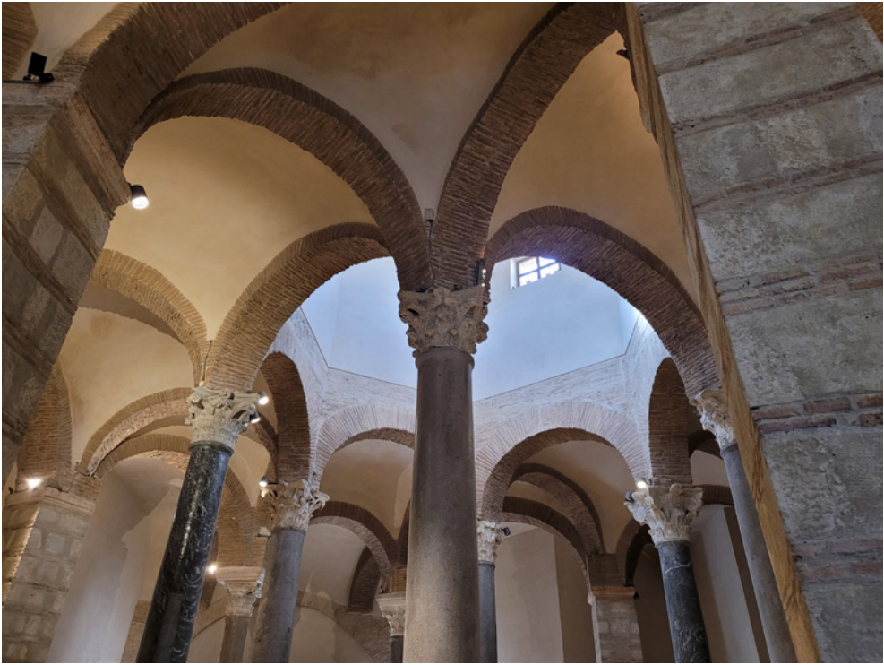
Fig. 2. Benevento, interno della chiesa di S. Sofia (fotografia Carlo Ebanista).
