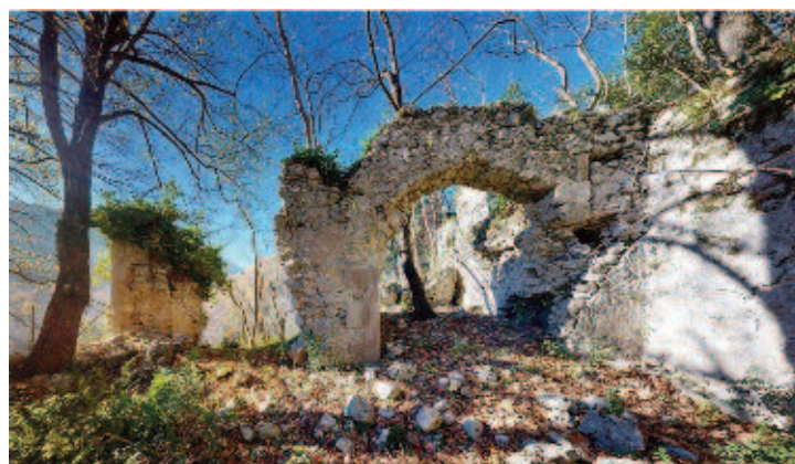
29. Vedute fotografiche degli ambienti interni dell'abbazia, con documentazione dei resti dell'antica chiesa, di un corpo scala e degli ambienti superiori, probabilmente destinati all'abate.
