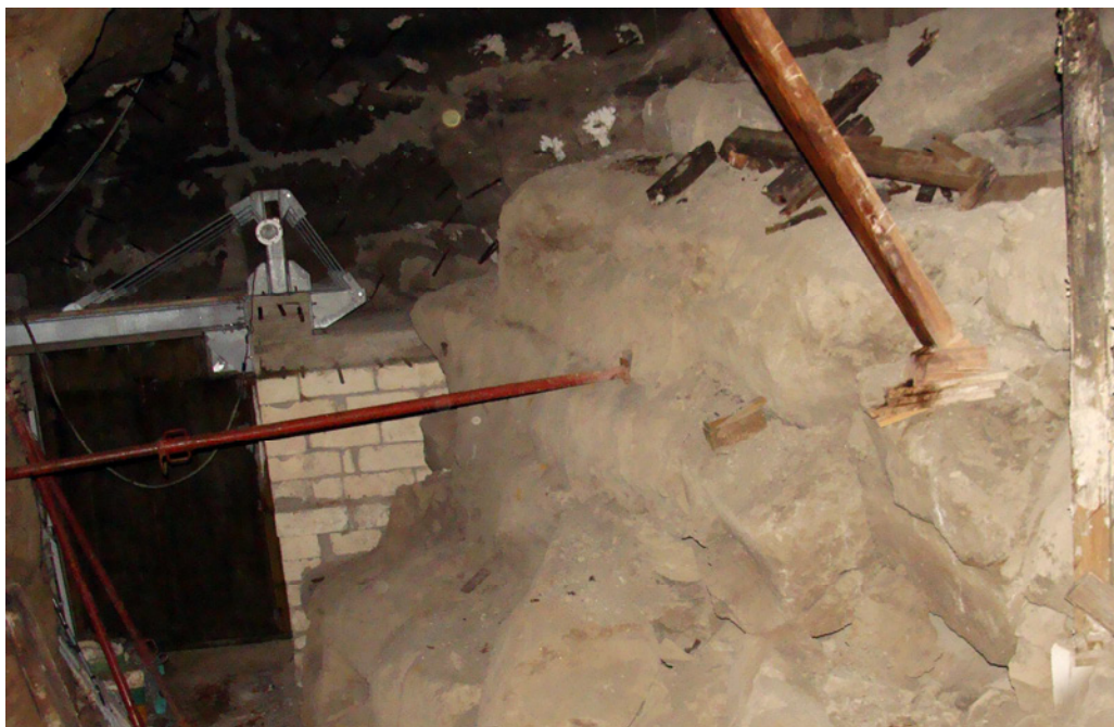
Fig. 6. Tratto iniziale di L visto dal livello di crollo presso il tratto mediano (foto G. Lacerenza, 2018).
