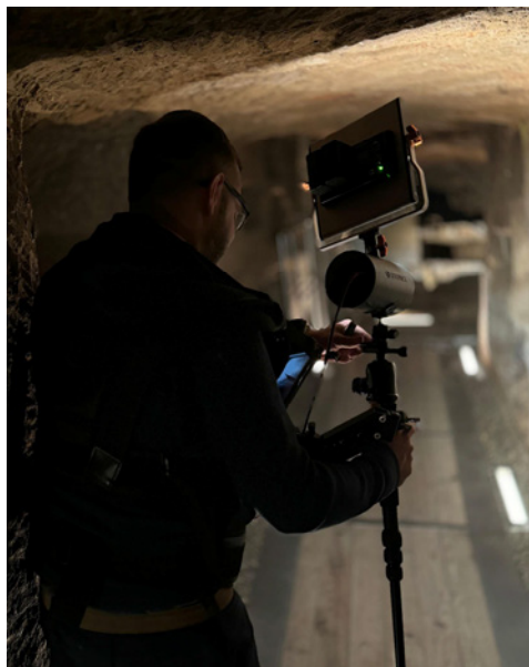
Fig. 8. Acquisizioni con lo Stonex XVS vSLAM 3D Scanner.
