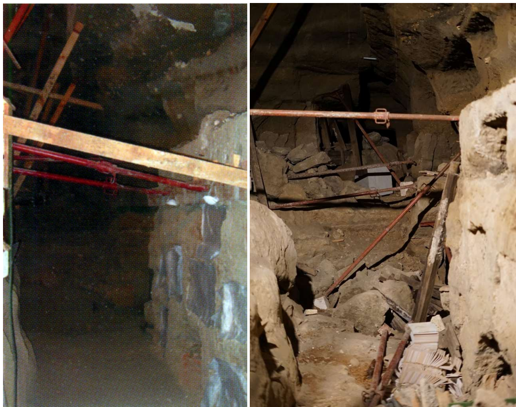
Fig. 5a (a sinistra). Tratto iniziale di L dopo la rimozione dei detriti (foto SABAP Basilicata, per gentile concessione).
