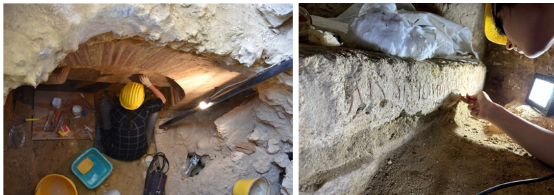
Fig. 38. Canosa di Puglia (loc. Lamapopoli); ipogeo H: attività di pronto intervento sui rivestimenti dell’arcosolio Ha (foto 2018; © Archivio Fotografico PCAS).
