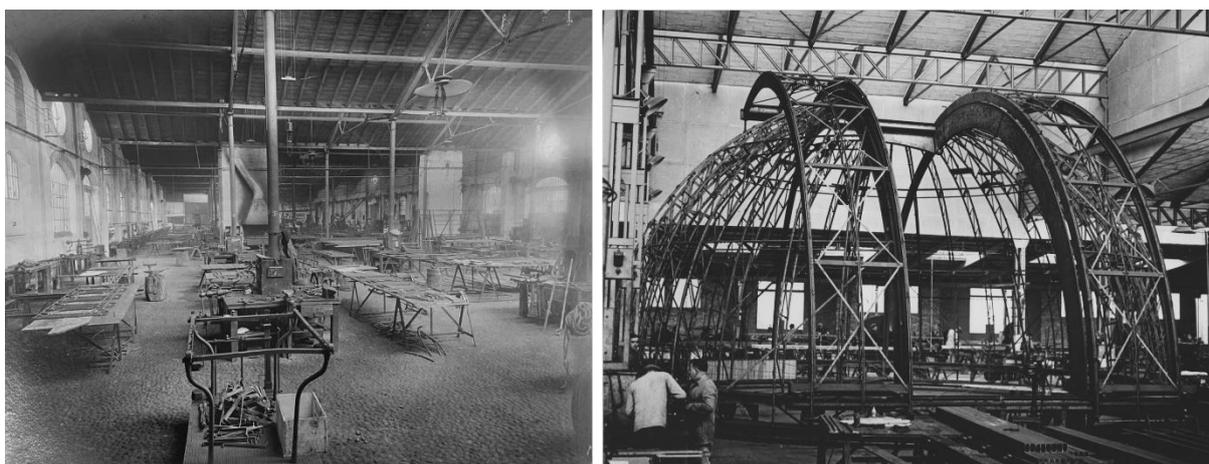
**Fig. 2.** Alcuni reparti delle officine A. Bombelli e maestranze all'opera all'interno del “Capannone Specole” durante la costruzione della cupola per il telescopio rifrattore Merz-Repsold del Regio Osservatorio Astronomico di Brera-stazione succursale di Merate, 1936 (Archivio A. Bombelli).
