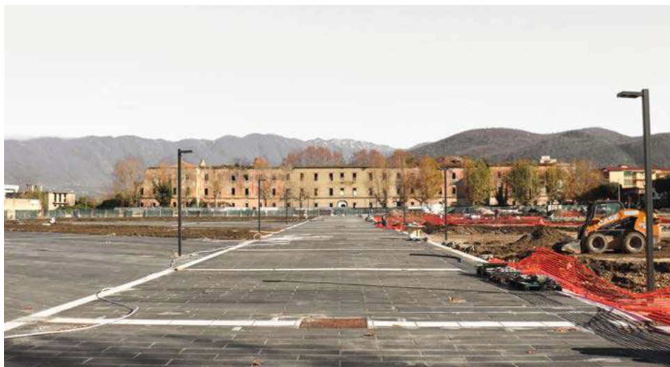
Foto del cantiere di Piazza d'Armi
