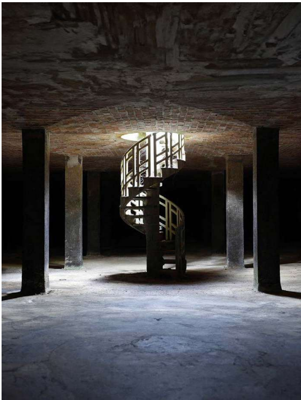
Sistemi di discesa per l'ispezione e manuten- zione: il primo piano. ©Alday Immobilier, per Atelier Montouro
