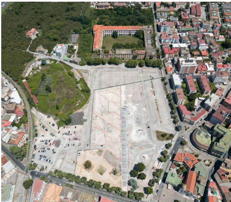
Foto del cantiere di Piazza d'Armi del 13.10.2024
