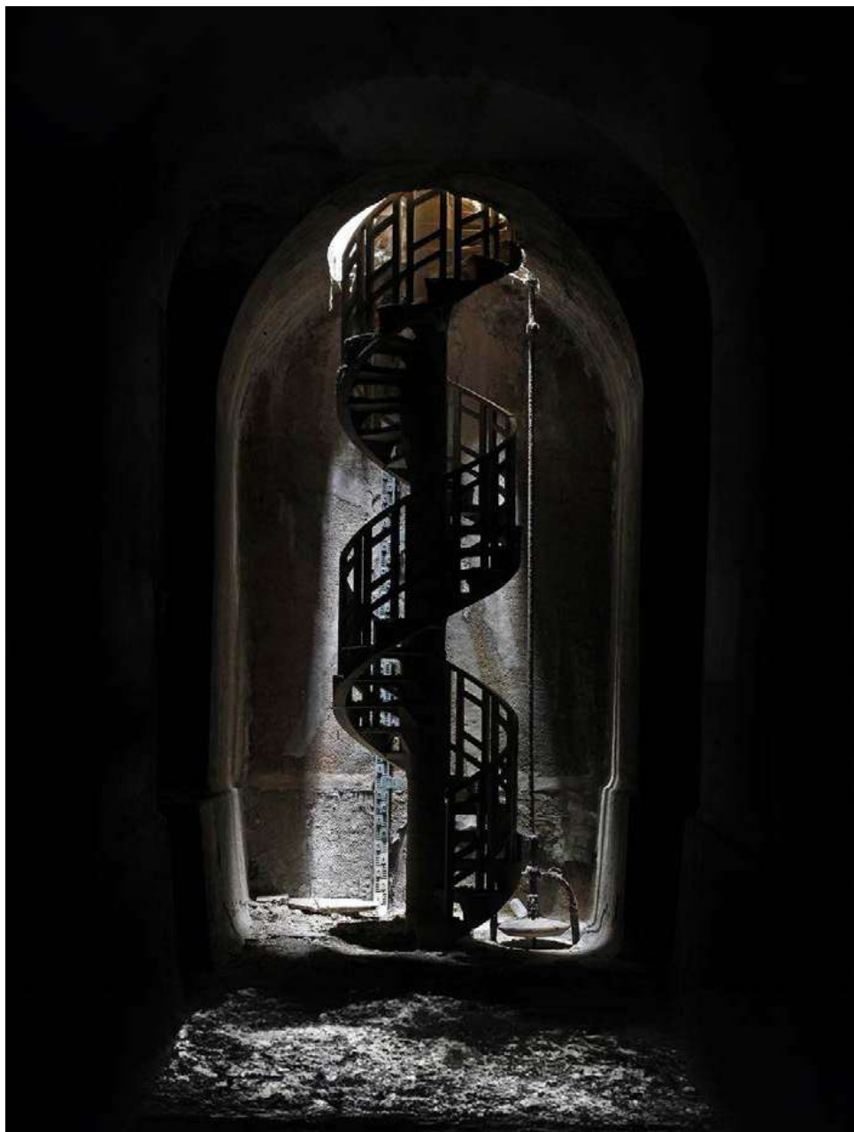
Sistemi di discesa per l'ispezione e manuten- zione: il piano terra ©Alday Immobilier, per Atelier Montouro
