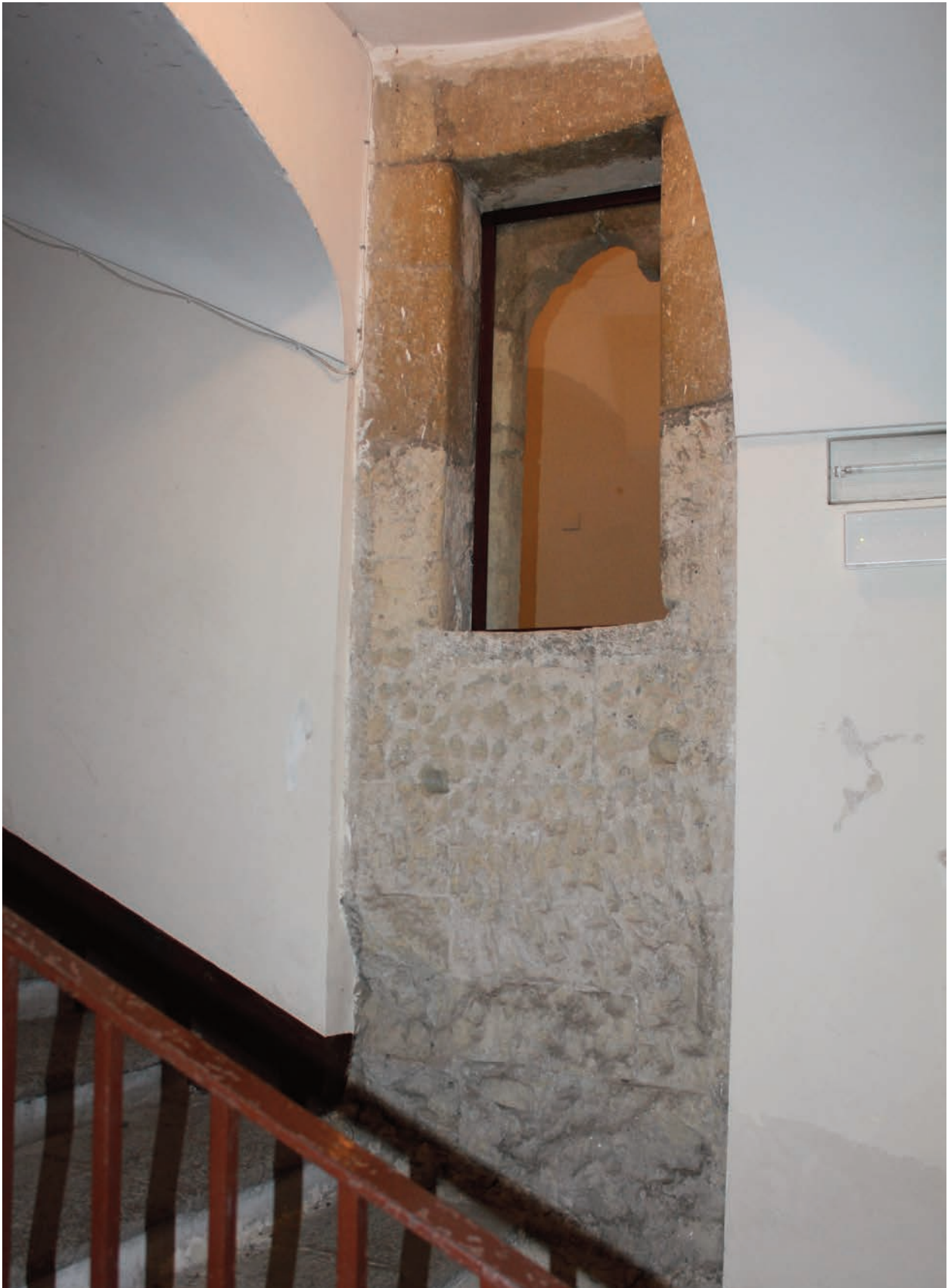
28. Complesso di s. Maria di Donnaregina. Gli avanzi della scala a chiocciola (E) visti dall'attuale scala di accesso al primo del coro
