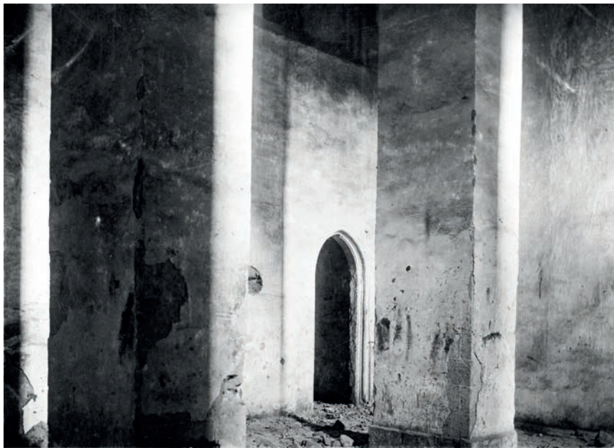
3. Piano terra, zona absidale. In primo piano due dei quattro pilastri che sostenevano il solaio e la porta che collega l'abside con l'esterno (FDRMNC)
