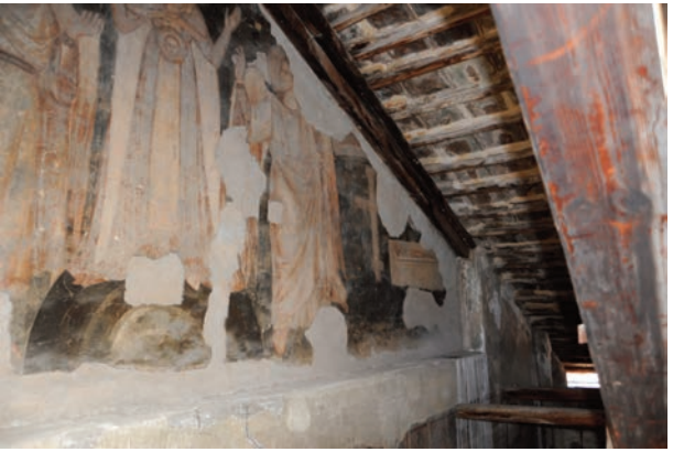
21. Sottotetto della Chiesa di s. Maria di Donnaregina. Onduline in materiale plastico poste al di sotto degli arcarecci esistenti tra la capriata n. 12 e il muro dell'abside per evitare infiltrazioni d'acqua
