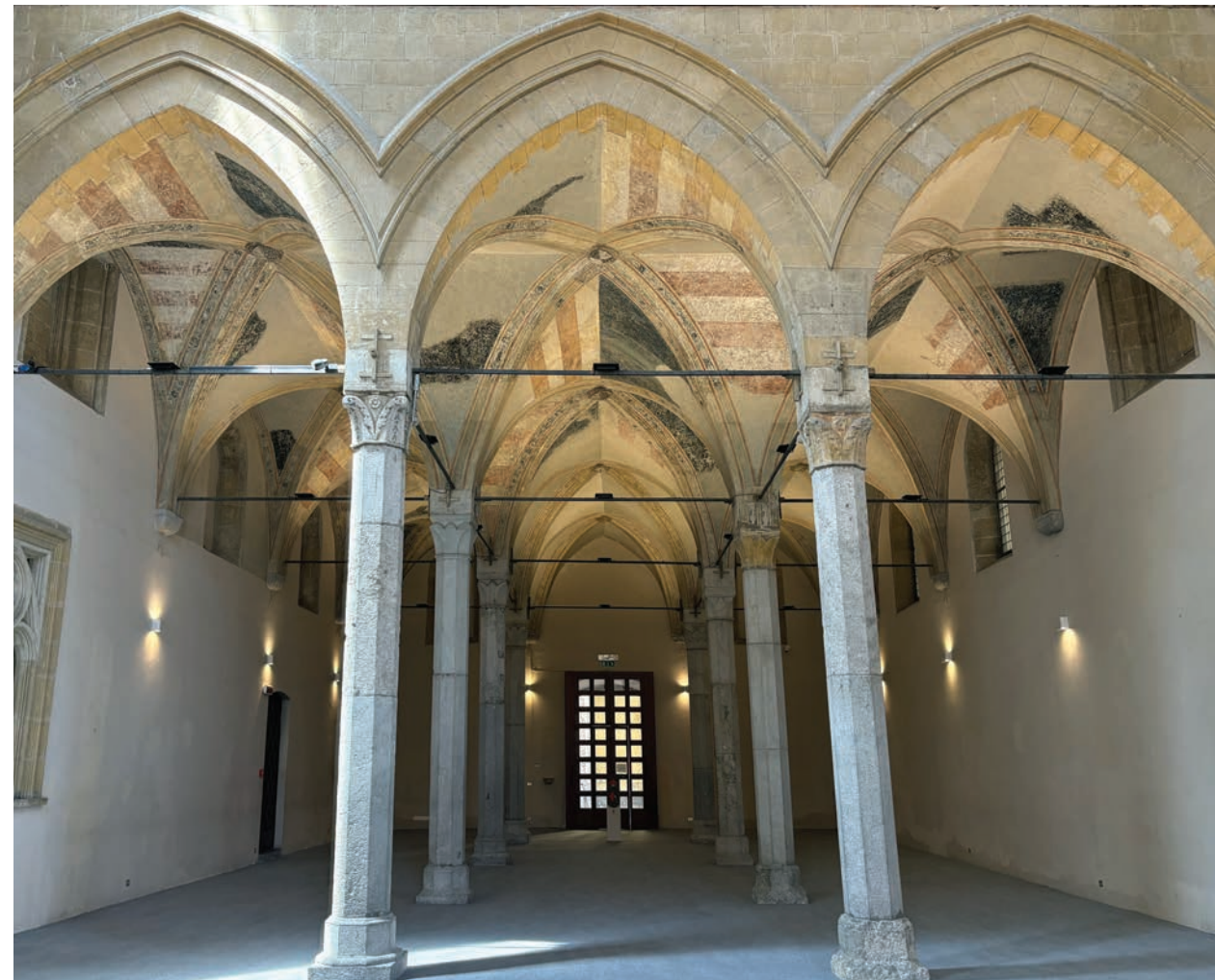
2. Chiesa di s. Maria di Donnaregina trecentesca. Vista delle volte che sorreggono il coro dal basso
