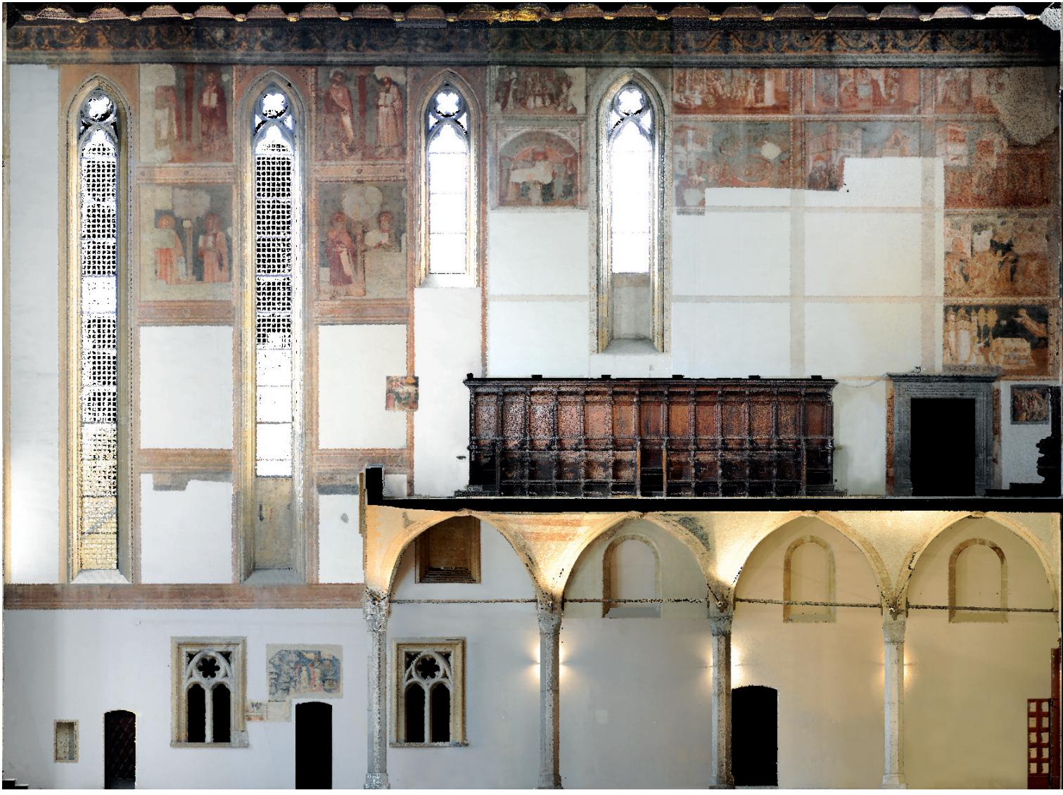
40. Complesso di s. Maria di Donnaregina. Ortofoto proiezione da nuvola dei punti della parete destra della chiesa
