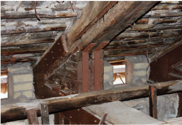
42. Sottotetto della Chiesa di s. Maria di Donnaregina. Le stuccheggiate eseguite nel corso dell'intervento di consolidamento del 1996. Il puntone ovest della capriata n. 2
