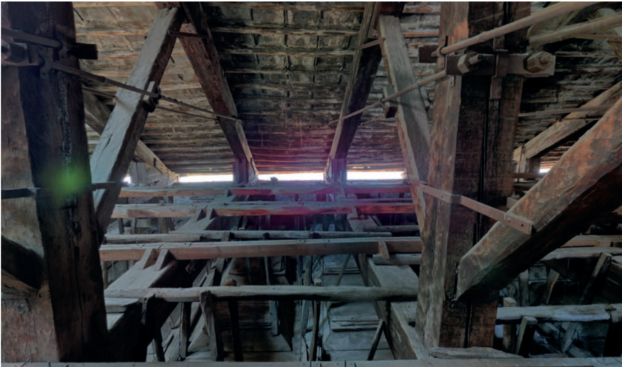
50. Sottotetto della Chiesa di s. Maria di Donnaregina. I gravi fenomeni di deterioramento del puntone est della capriata n. 4. Vista del modello generato dalla nuvola dei punti acquisita
