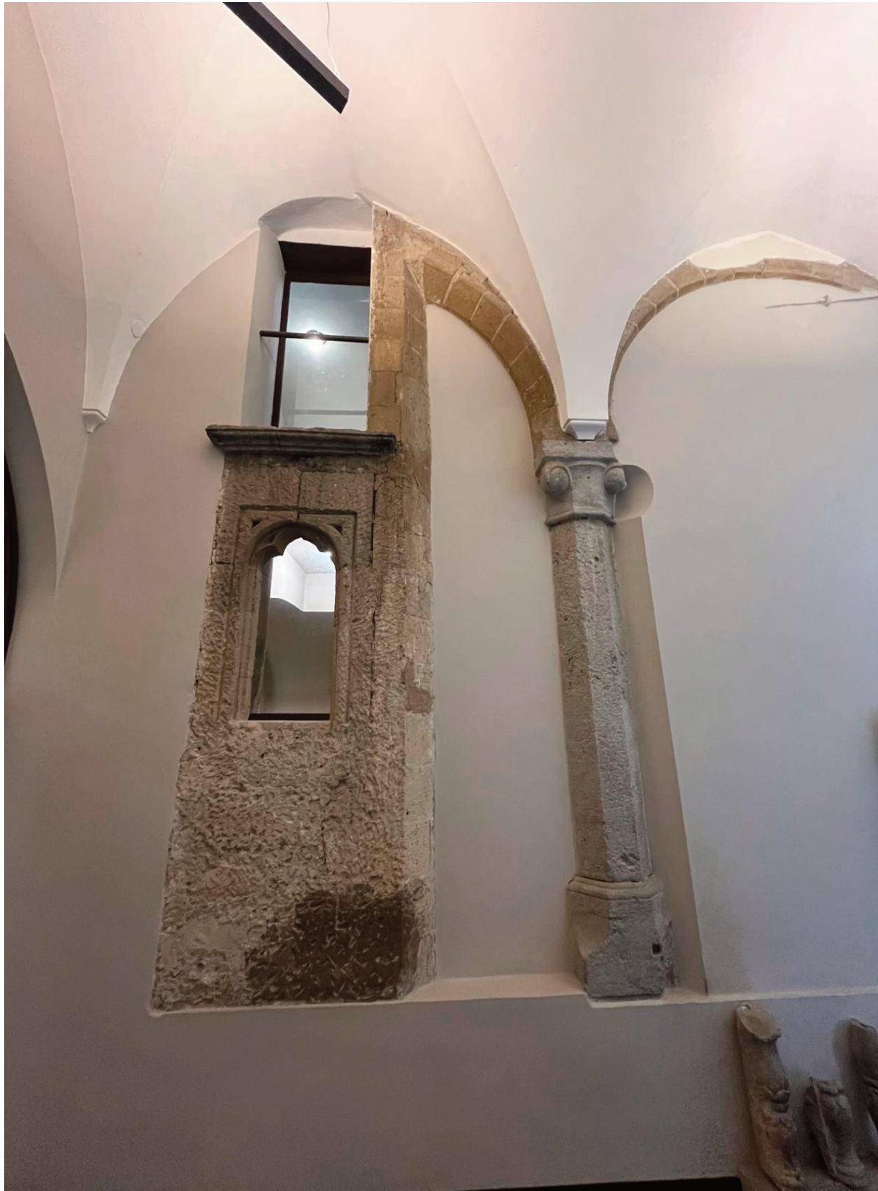
27. Complesso di s. Maria di Donnaregina. Gli avanzi della scala a chiocciola (E). Si noti che la struttura della scala interrompe l'arco: ciò induce a ritenere – contrariamente a quanto sostenuto da Chierici – che la scala e l'arco del porticato non siano coevi. Purtroppo, non è stata ritrovata una documentazione grafica o fotografica tale da documentare la consistenza di quanto messo alla luce da Chierici prima del restauro, per tentare di procedere ad una nuova analisi che tenga conto del fatto che quando fu realizzata la nuova chiesa trecentesca erano ancora presenti le strutture del complesso più antico di s. Pietro a Montes a Donnaregina
