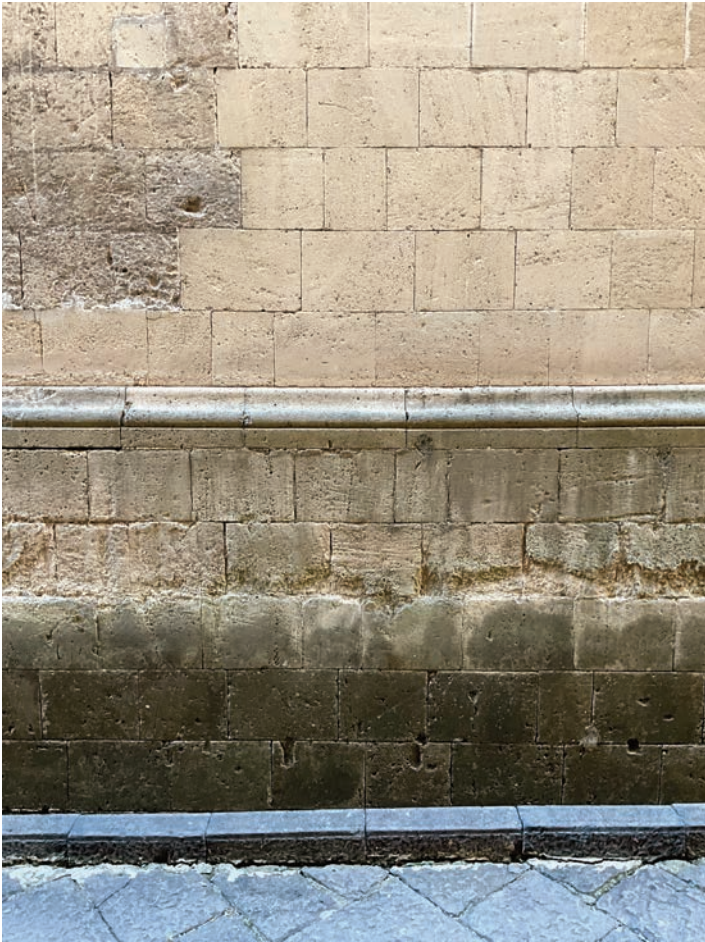
52. Chiesa di s. Maria di Donnaregina. Parte bassa del prospetto su vico Donnaregina. Fenomeni di degrado riconducibili al ruscellamento delle acque meteoriche sulle pareti. Sono visibili macchie, croste e biodeteriogeni autotrofi come muschi e licheni
