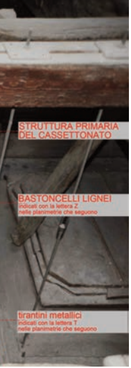
25. Sottotetto della Chiesa di s. Maria di Donnaregina. Particolare dell'estradosso del cassettonato con l'individuazione delle diverse strutture che lo sostengono
