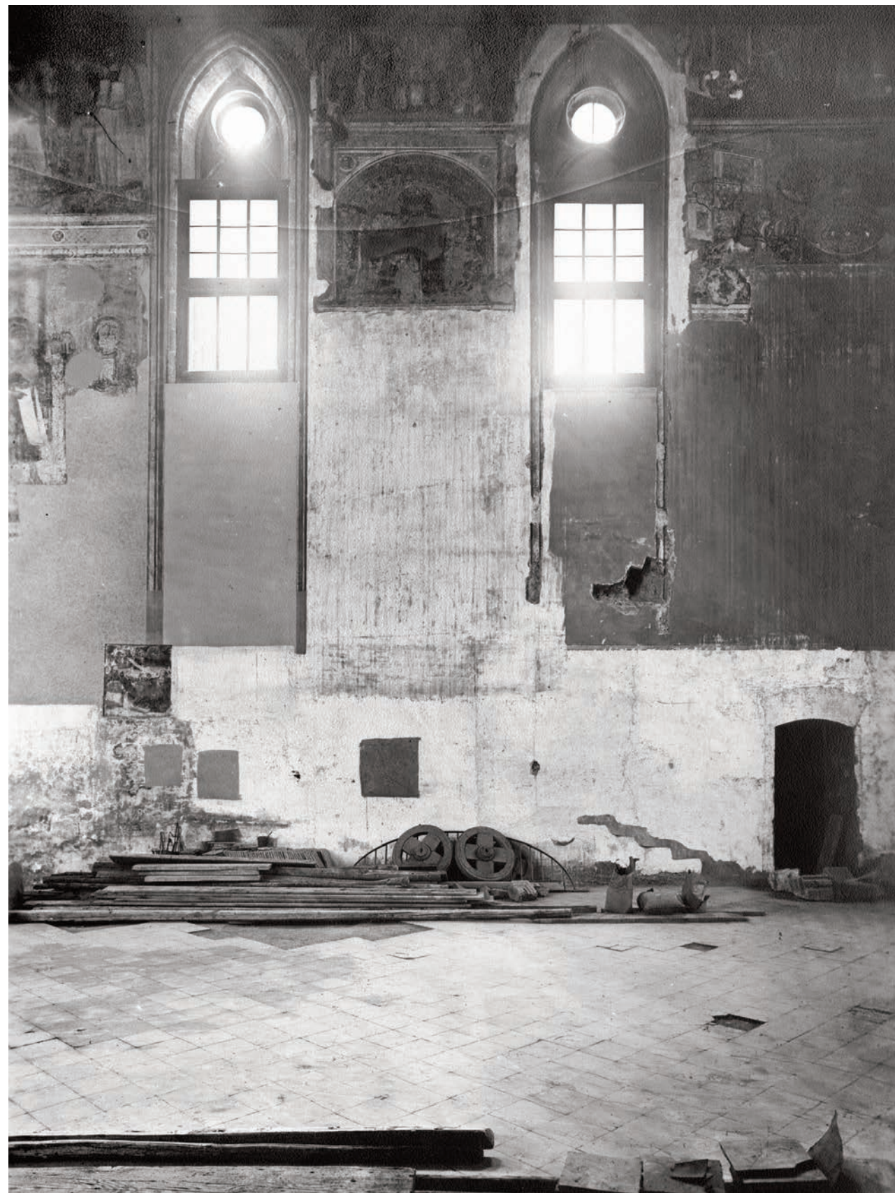
17. Coro delle monache. Gli affreschi della parete sinistra con le Storie di sant'Agnese e santa Caterina, prima dei restauri (AF SABAPNa)
