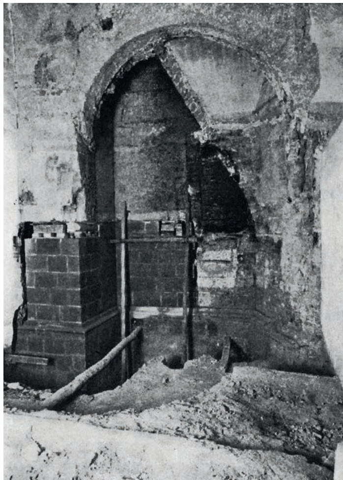
15 I lavori di ripristino dell'abside (AF SABAPNa)
