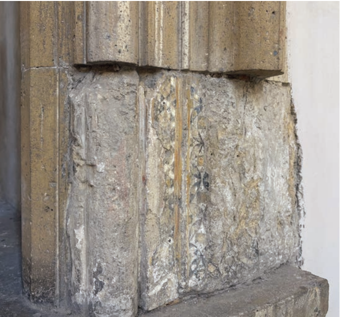
43. Complesso di s. Maria di Donnaregina. Particolare della bifora della Cappella Loffredo: in primo piano le parti originarie con i frammenti dell'originario rivestimento in intonaco colorato
