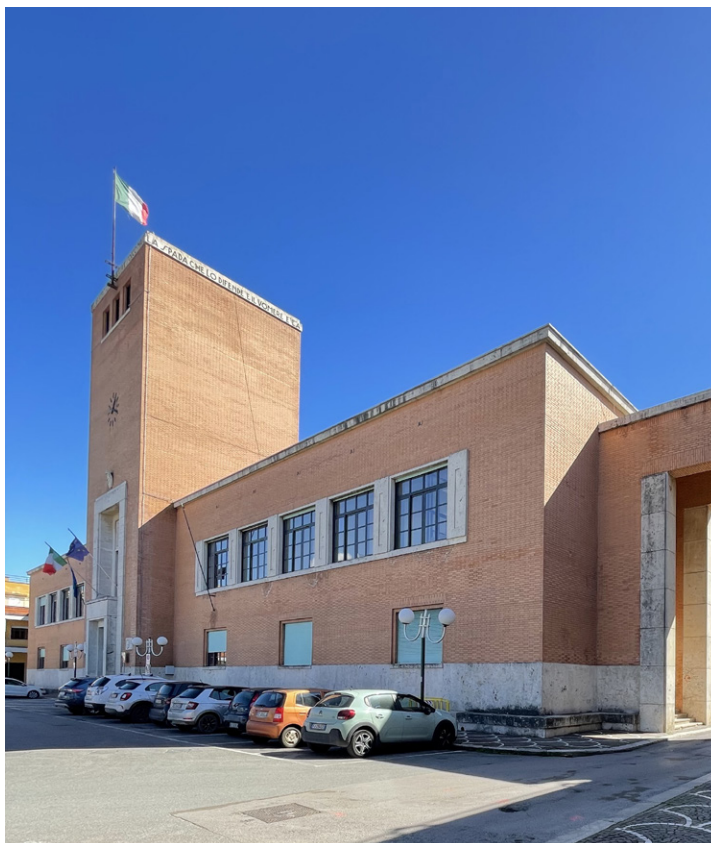
fig. 5 Vista della piazza principale. fig. 6 Palazzo municipale di Pontinia.
