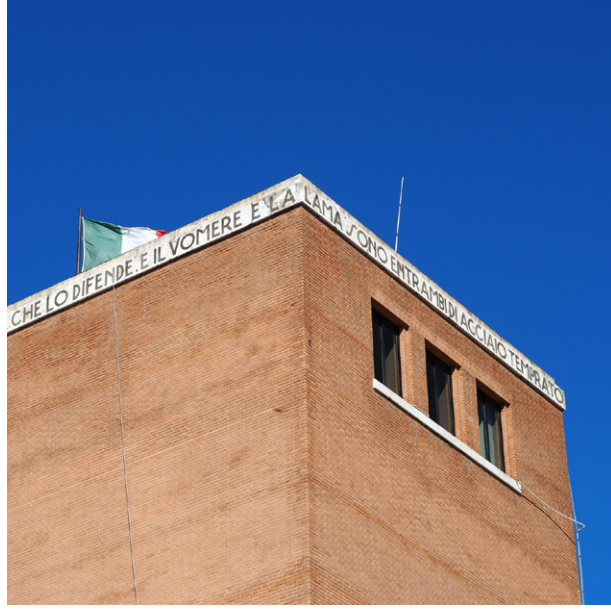
Dettaglio della torre del Palazzo del Municipio
