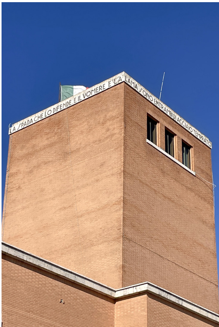
fig. 2 Scorcio della Torre idrica a Pontinia. fig. 3 Asse di via C. Battisti e Chiesa di Sant'Anna. fig. 4 Dettaglio della torre del municipio di Pontinia. ©Mario Galterisi.
