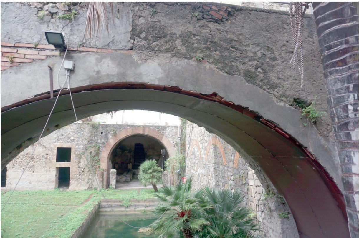
Fig. 19. Particolare dell'arco di passaggio tra il giardino e il porticato esterno ricostruito. Si noti il degrado della struttura in calcestruzzo armato e la lamiera metallica realizzata recentemente per mettere in sicurezza l'area.
