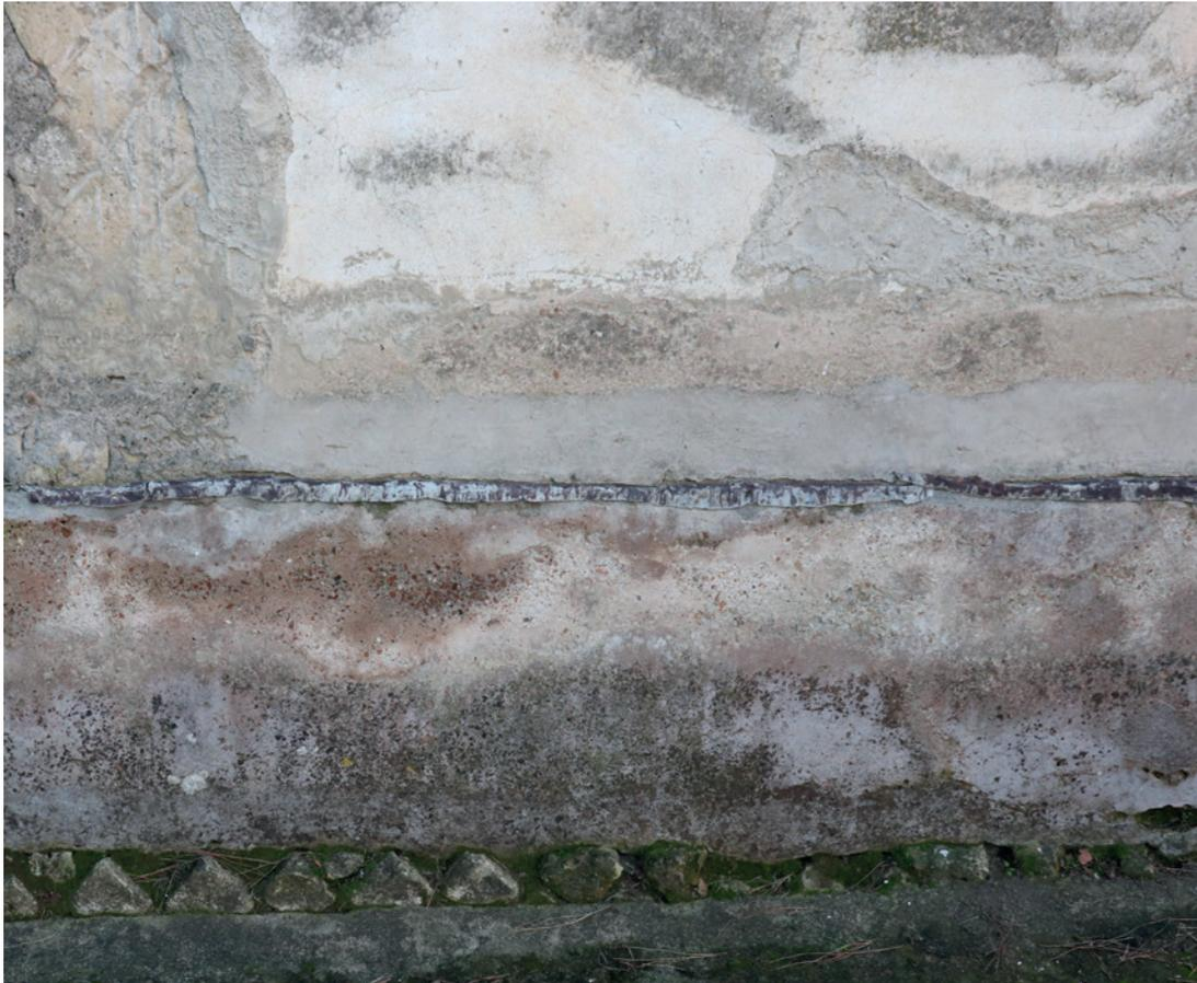
Fig. 8. Lamina in piombo inserita durante gli interventi degli anni Cinquanta come barriera all'umidità di risalita (foto dell'autore 2019).
