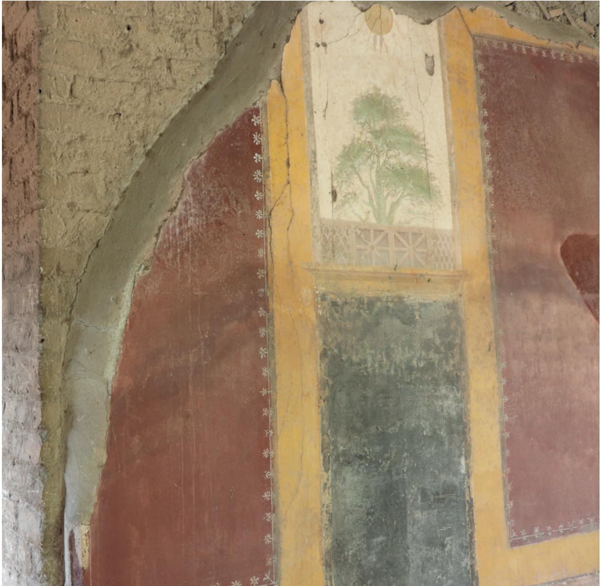
Fig. 7. Stucature di bordo in malta cementizia applicate negli anni Cinquanta per il consolidamento dei lacerti di intonaco (foto dell'autore 2019).
