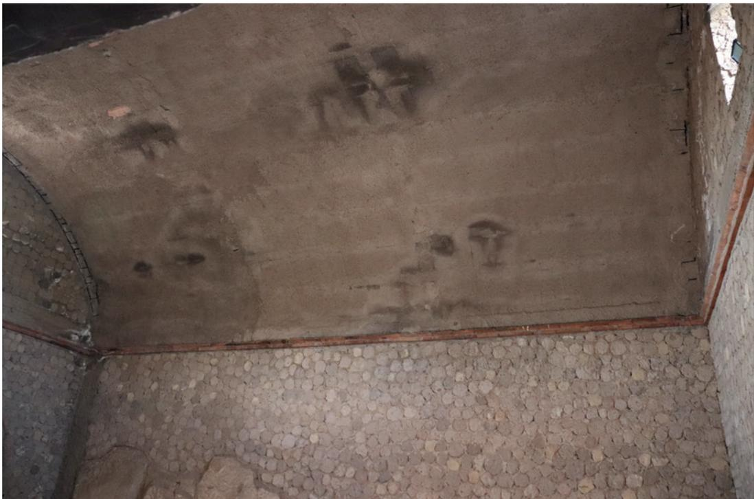
Fig. 6. Copertura voltata del *calidarium* realizzata in laterocemento durante gli anni Cinquanta. Si notino il pessimo stato di conservazione, determinato dalla caduta dei copriferrì e dalla presenza di macchie di umidità da infiltrazione, e i paramenti ricostruiti in opera incerta sulla muratura antica (foto dell'autore, 2019).
