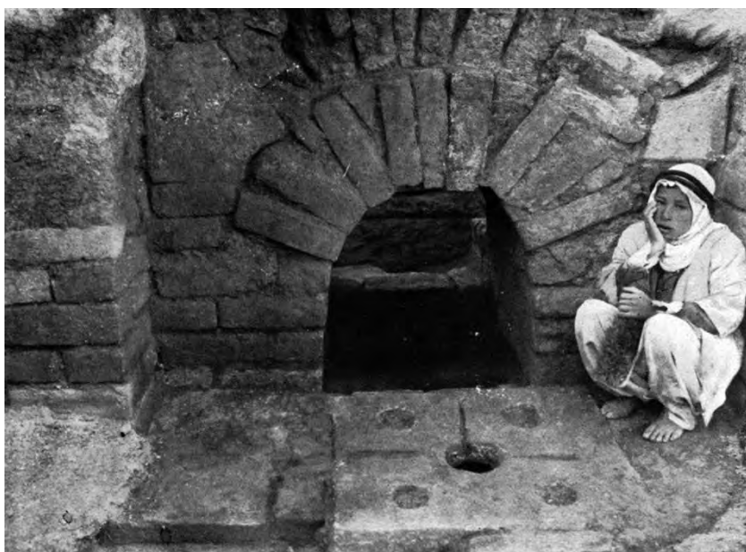
Fig. 5a-b - La Camera delle Abluzioni (Ablution Room) nel Palazzo del Governatore a Nimrud con il foro di drenaggio circondato da quattro incavi circolari (Mallowan 1950, tav. XXXI).
